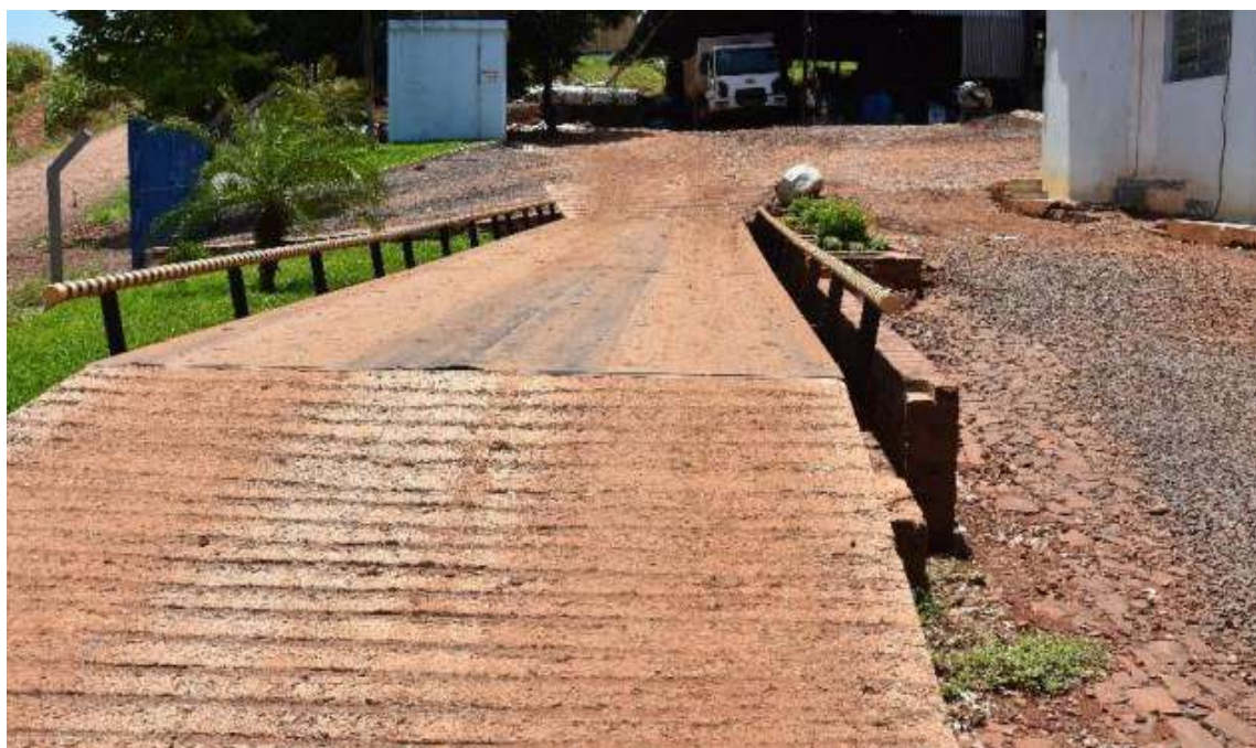
Figura 15 - Balança de pesagem dos caminhões.
