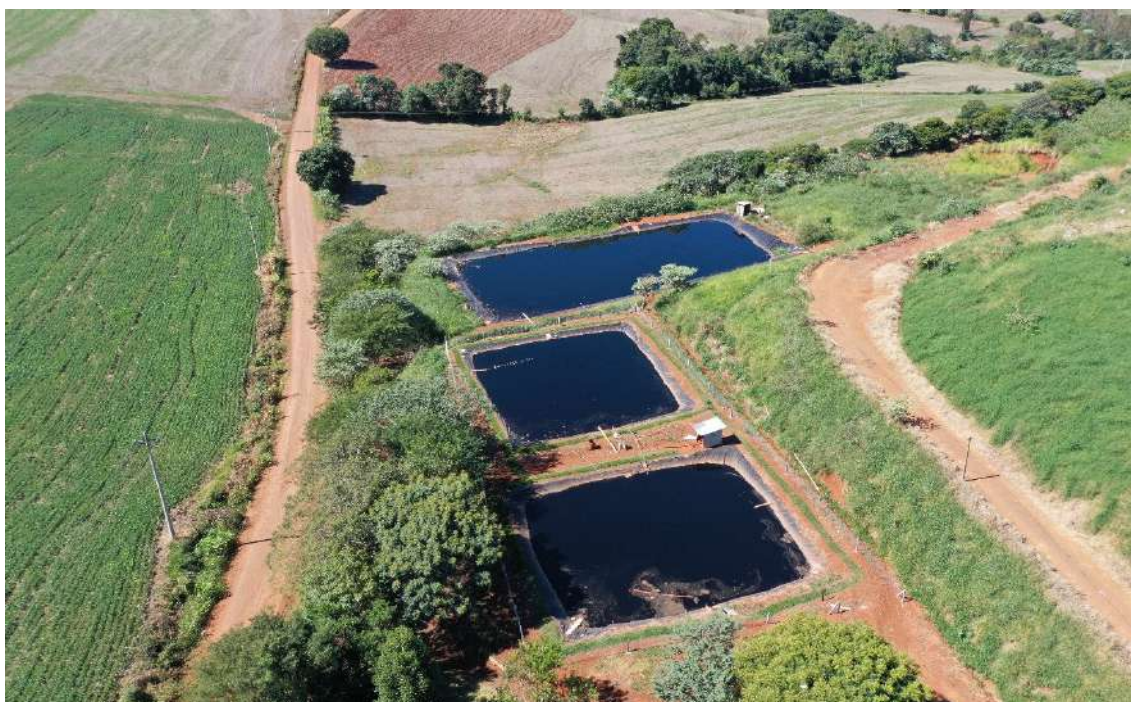
Figura 20 - Estação de tratamento de efluentes líquidos.
